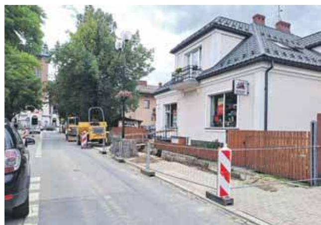
Nowe przyłącza do sieci na ul. Kazimierza Wielkiego.
