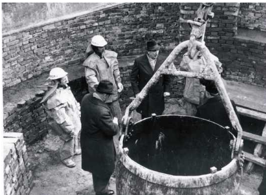
Materiał LW Bogdanka - moment wmurowania aktu erekcyjnego pod budowę kopalni w LZW w 1975 roku
