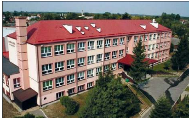
Budynek ZPO w Łomazach przejdzie gruntowną modernizację
