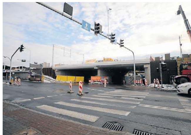
Zmiany w ruchu i komunikacji miejskiej. Autobusy będą przejeżdżać pod wiaduktem na ul. Mikołowskiej
