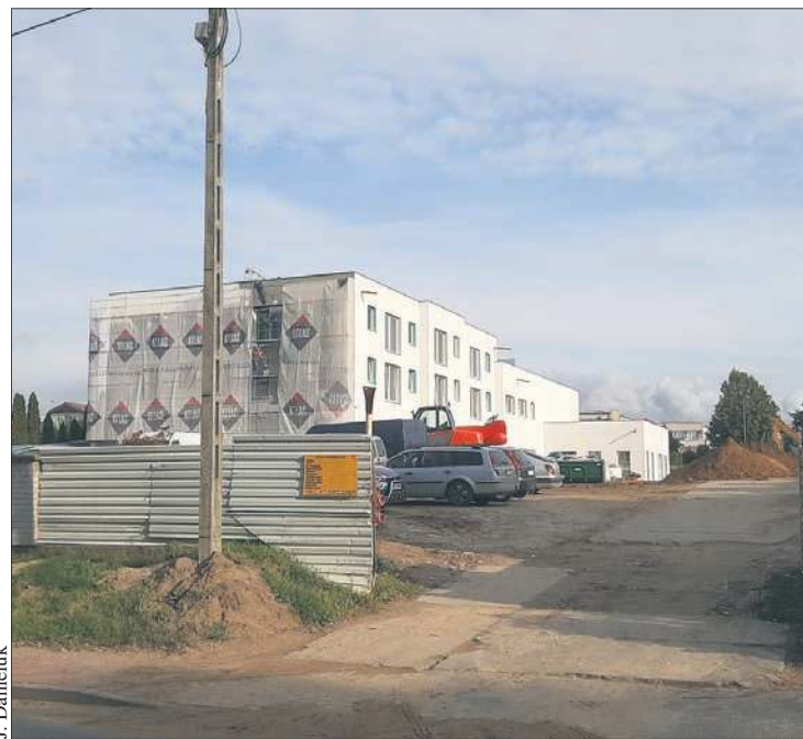
Budowa żłobka pomiędzy ulicami Polną i Kazimierza Wielkiego
