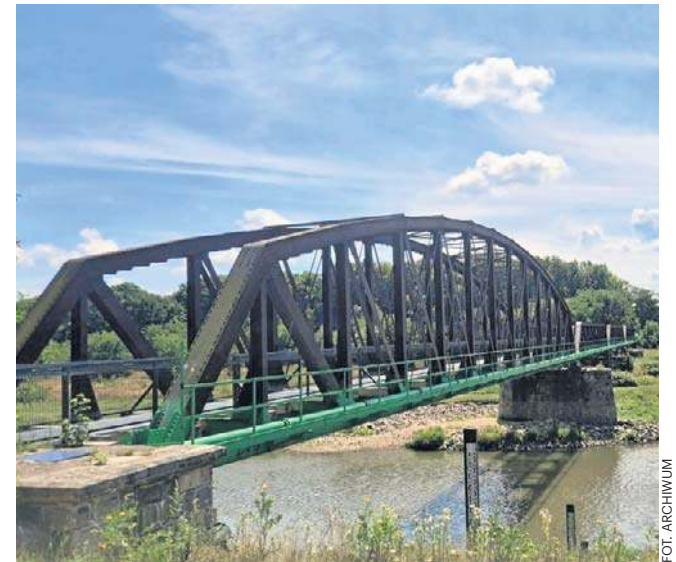
W ubiegłym roku powstała kładka technologiczna. Było to rozwiązanie przejściowe, ale bardzo potrzebne.
