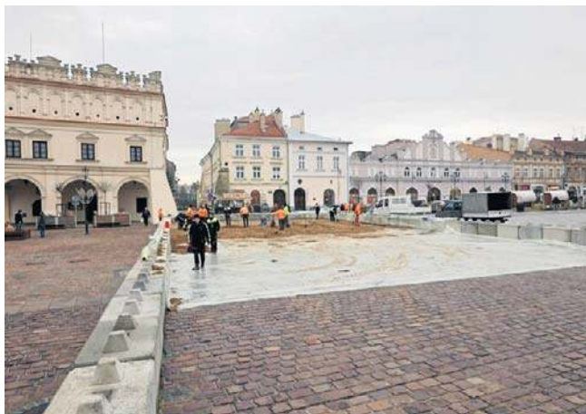
Firma zewnętrzna instaluje stelaż, na którym zostanie wylane lodowisko
