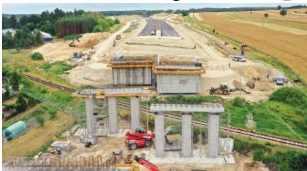
Budowa drogi ekspresowej S17 na odcinku Tomaszów Lubelski Południe – Hrebennie zbliża się do półmetka. Fot. GDDKiA Lublin
