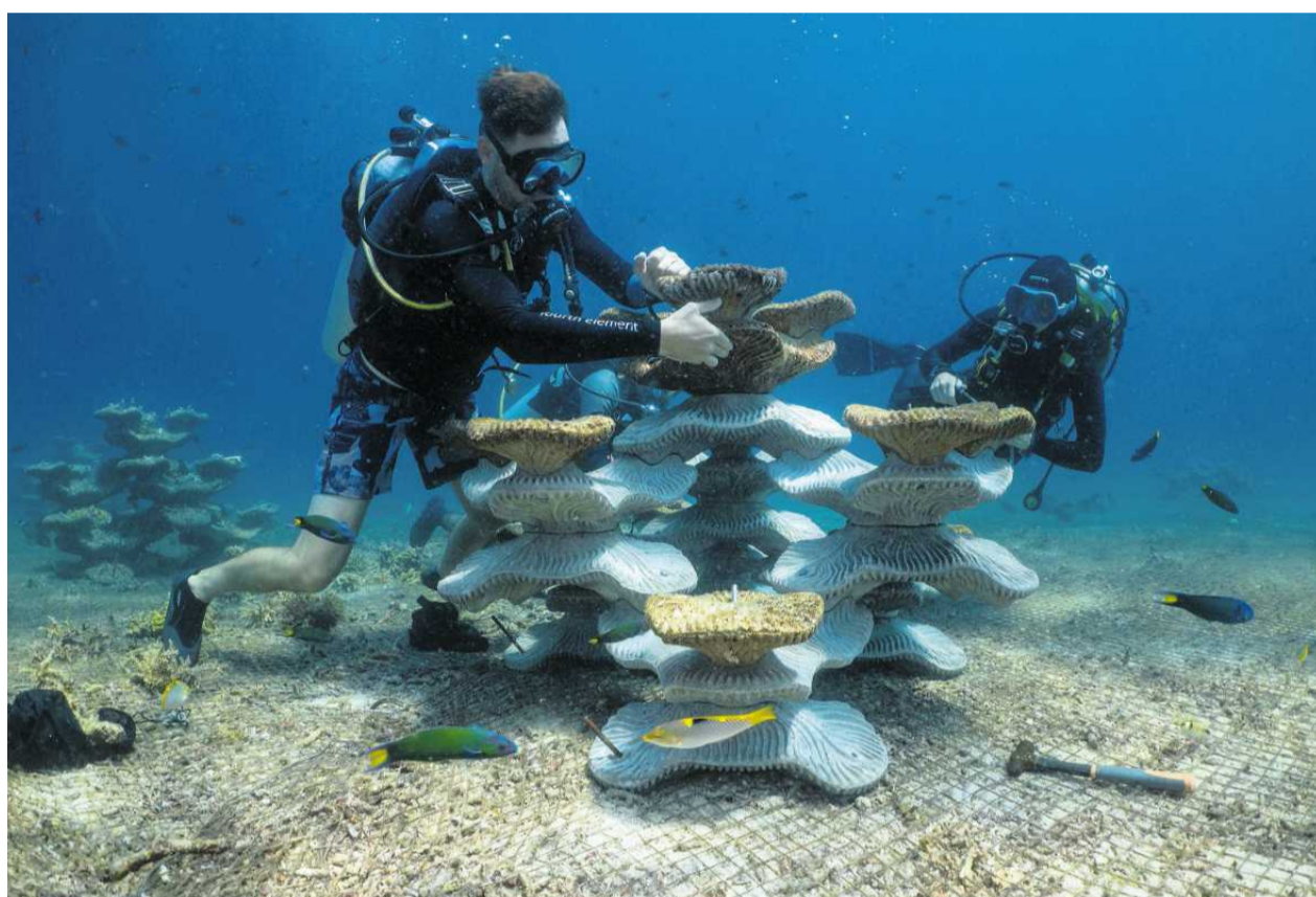
• Robin Philippo, wraz z innym nurkiem z Centrum Badań i Ochrony Tropików, montują modułową konstrukcję sztucznej rafy u wybrzeży wyspy Pom Pom w północno-wschodniej Malezji, 15 kwietnia 2026 r. FOT. SIRACHAI ARUNRUGSTICHAJ/THE NEW YORK TIMES
