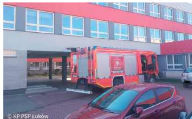
W budynku Szkoły Podstawowej nr 5 im. gen. Władysława Sikorskiego w Łukowie doszło do pożaru w szybie windy
