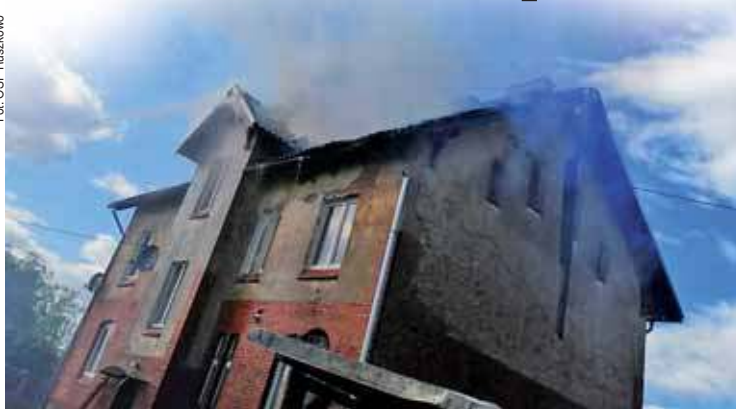
Pożar przeniół się z garaży na dom wielorodzinny
