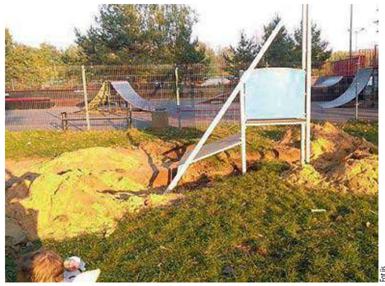
Park na osiedlu Fabrycznym - rozkopy przy skateparku
