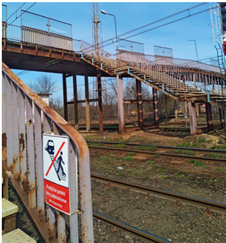
Kładka w Brzegu Dolnym
