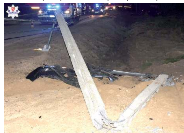
Według policji o nadmiernej prędkości auta może świadczyć siła, z jaką pojazd uderzył w betonowy słup trakcji elektrycznej, powodując jego pęknięcie
