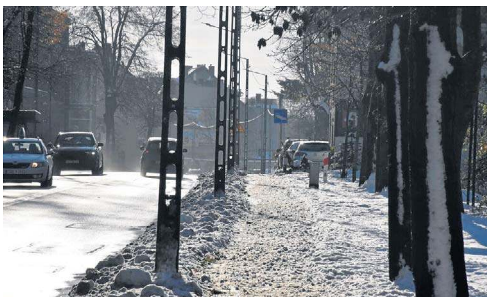
Niektóre odcinki DK 55, mimo remontów, nie przypominają standardem drogi krajowej
