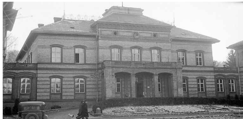
Budynek Dyrekcji Państwowego Ośrodka Szkolenia Inwalidów Wojennych w Lęborku
