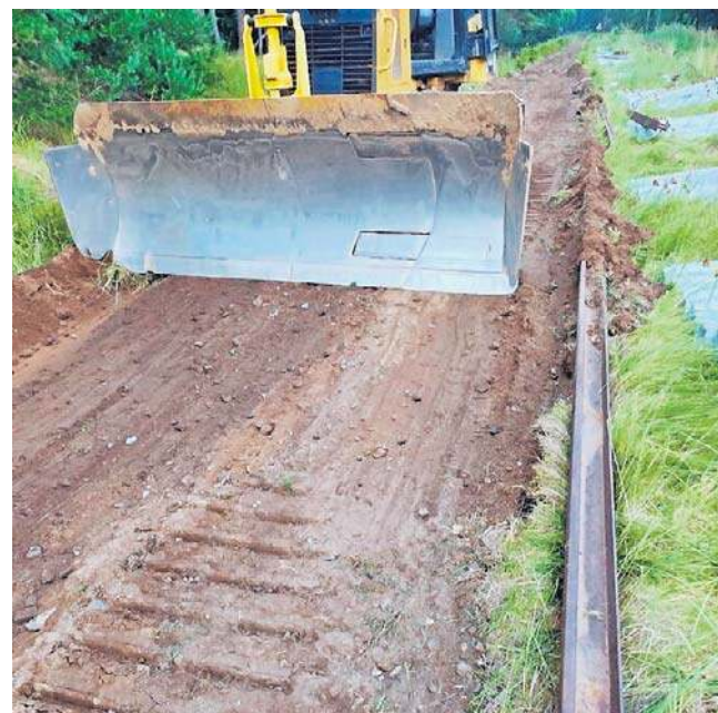
Prowadzone są kolejne etapy remontu torowiska
