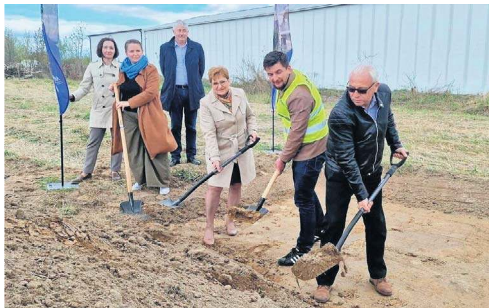
Uczestnicy wydarzenia podczas symbolicznego wbicia pierwszej łopaty na placu budowy przy ulicy Tomaszowskiej w Nowym Mieście nad Pilicą.
