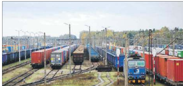
Z informacji ministerstwa infrastruktury wynika, że do końca czerwca mają ruszyć prace przygotowawcze związane z rozbudową portu w Małaszewiczach
