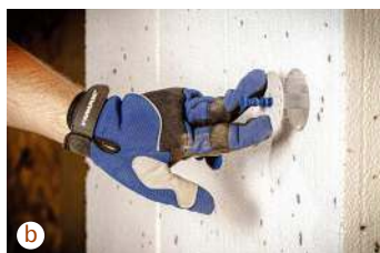
❶ Wywiercenie otworu w styropianie o odpowiedniej średnicy i głębokości (a), osadzenie kołka (b), dokręcenie wkrętu kołka do momentu osiągnięcia odpowiedniej głębokości zakotwienia (talerz powinien być zagłębiony na ściśle określonej głębokości) (c), uzupełnienie ubytku powierzchni zaślepką ze styropianu (d). RAWLPLUG
