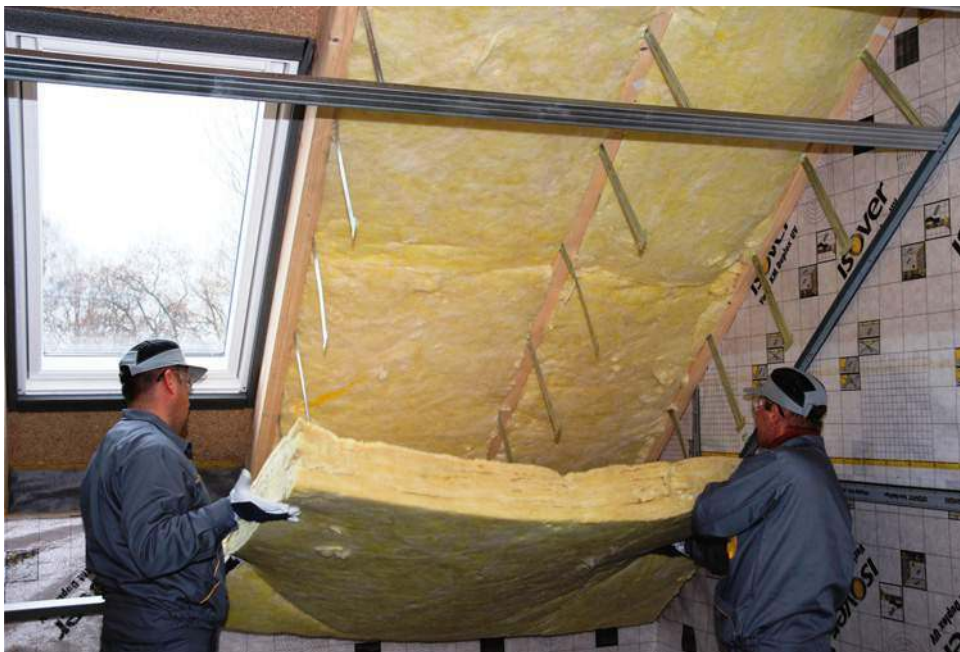
🔧 Dachy skośne izoluje się z reguły wełną mineralną, która bardzo dokładnie wypełnia ocieplaną przestrzeń. ISOVER
