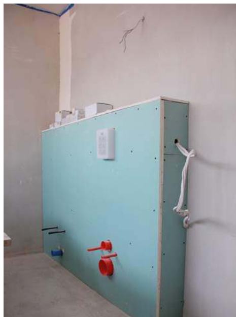
Do pomieszczeń wilgotnych przeznaczone są specjalne rodzaje płyt g-k. Zabudowuje się nimi np. stelaże WC. J. WERNER
