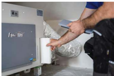
b Jedną z podstawowych zalet wentylacji mechanicznej jest możliwość filtrowania doprowadzanego powietrza. PRO-VENT
