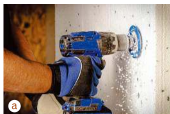
❶ Wywiercenie otworu w styropianie o odpowiedniej średnicy i głębokości (a), osadzenie kołka (b), dokręcenie wkrętu kołka do momentu osiągnięcia odpowiedniej głębokości zakotwienia (talerz powinien być zagłębiony na ściśle określonej głębokości) (c), uzupełnienie ubytku powierzchni zaślepką ze styropianu (d). RAWLPLUG
