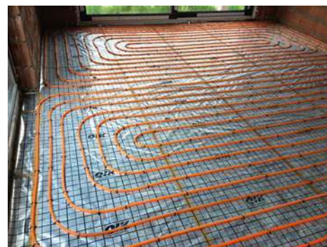
Modeli kondensacyjne pracują najefektywniej w połączeniu z niskotemperaturowym ogrzewaniem podłogowym. RWC
