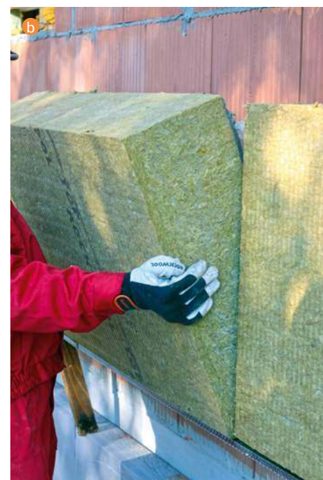
Domy izoluje się przeważnie styropianem (a KNAUF THERM) lub wełną mineralną (b ROCKWOOL). Oba materiały wyróżniają się bardzo dobrymi właściwościami cieplnymi – ich współczynniki \lambda wynoszą zwykle 0,031–0,045 W/(m \cdot K) .
