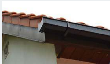
Na obróbkach z miedzi założono orynnowanie z PVC, najpierw w okrągłym, teraz w prostokątnym kształcie.
