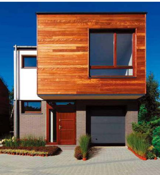
Do wykonania elewacji z drewna termowanego można użyć systemu z niewidocznymi mocowaniami. JAF POLSKA
