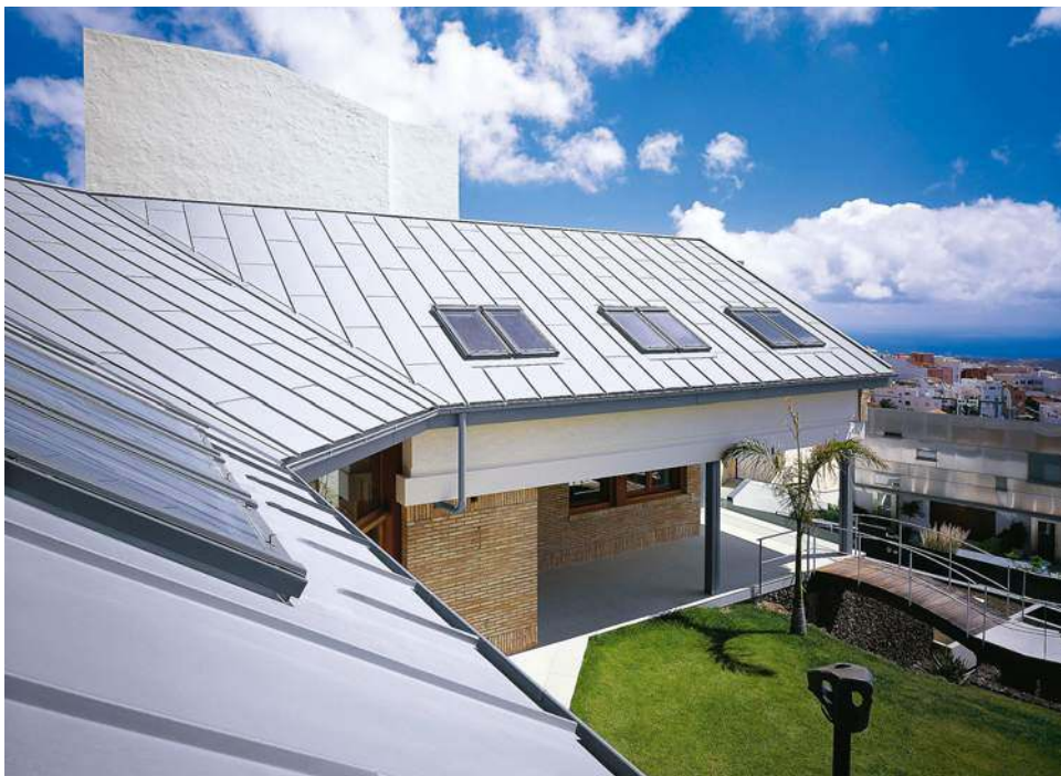
🔗 Blacha płaska w wersji luksusowej, czyli niewymagające konserwacji pokrycie z tytan cynku. RHEINZINK
