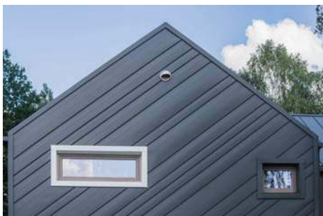
🔗 Płaską blachą można również wykończyć elewację. BLACHPROFIL 2
