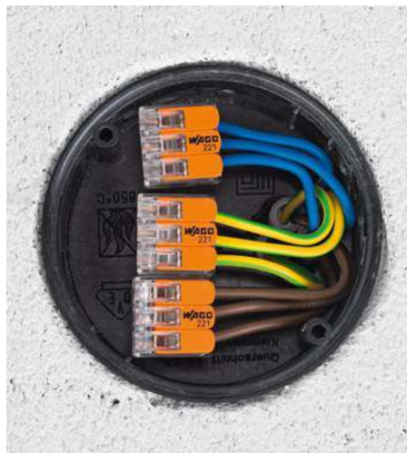
🔌 Do łączenia przewodów w instalacji oraz podłączenia lamp należy używać tylko specjalnych złączek. Gwarantują to uzyskanie bezpiecznego, pewnego styku elementów. WAGO-ELWAG
