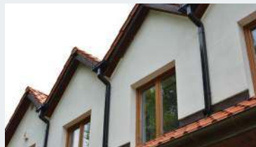
Nowe i stare elementy systemu rynnowego – w I etapie remontu założono je przy oknach w lukarnach.
