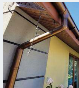
🔗 Zastosowałem system z PVC, rynny o przekroju 150 mm i rury spustowe 100 mm.
