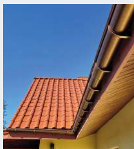
🔗 Haki pod rynnami właściwie przymocowałem gęsto, co 0,50 m.
