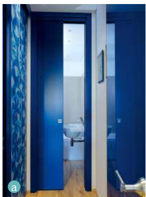
🔗 Drzwi przesuwne z kasetą schowaną w ścianie (a ECUSSE) i składane (b DRE).
