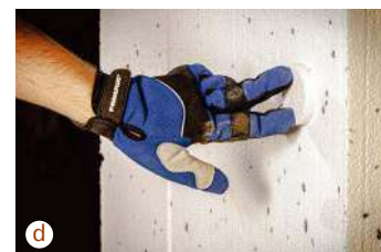
❶ Wywiercenie otworu w styropianie o odpowiedniej średnicy i głębokości (a), osadzenie kołka (b), dokręcenie wkrętu kołka do momentu osiągnięcia odpowiedniej głębokości zakotwienia (talerz powinien być zagłębiony na ściśle określonej głębokości) (c), uzupełnienie ubytku powierzchni zaślepką ze styropianu (d). RAWLPLUG
