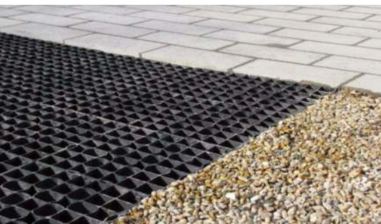
🌱 Kratki z PVC najprościej zasypać kruszywem, które nadaje nawierzchni stabilność i umożliwia szybkie przesiekanie wody deszczowej w głąb gruntu. ECOMAX
