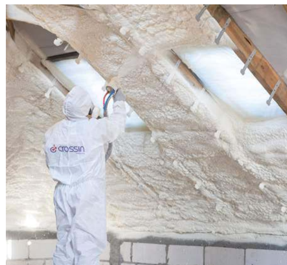
Pianka poliuretanowa w postaci płynnej służy do ocieplania dachu metodą natryskową. PCC PRODEX
