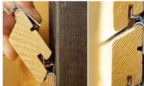
Do wykonania elewacji z drewna termowanego można użyć systemu z niewidocznymi mocowaniami. JAF POLSKA
