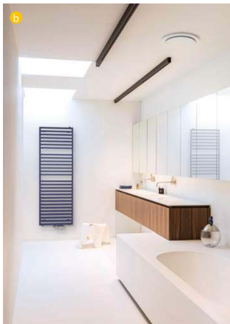
📍 Kratka wentylacyjna – tu zaczyna się kanał wywiewny wentylacji grawitacyjnej (a FOTOLIA). W wentylacji mechanicznej zamiast kratki mamy anemostaty na suficie (b VASCO).
