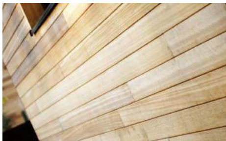
Do wykonania elewacji z drewna termowanego można użyć systemu z niewidocznymi mocowaniami. JAF POLSKA
