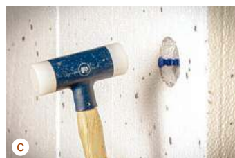
❶ Wywiercenie otworu w styropianie o odpowiedniej średnicy i głębokości (a), osadzenie kołka (b), dokręcenie wkrętu kołka do momentu osiągnięcia odpowiedniej głębokości zakotwienia (talerz powinien być zagłębiony na ściśle określonej głębokości) (c), uzupełnienie ubytku powierzchni zaślepką ze styropianu (d). RAWLPLUG
