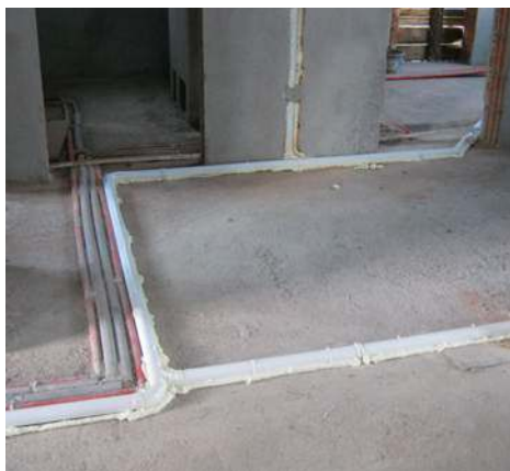
🔧 Rurociąg (na zdjęciu to białe rury na pianie) najłatwiej rozprowadzić na etapie stanu surowego. TOPVAC
