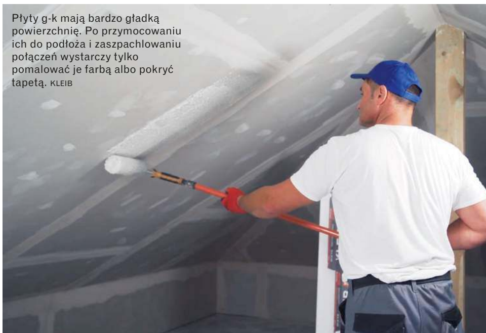
Standardowe wymiary płyty g-k to 12,5 mm grubości, 1200 mm szerokości i 2000–3000 mm długości. RIGIPS
