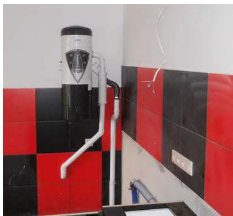
🔧 Jednostkę centralną montuje się w pomieszczeniu gospodarczym, np. garażu, kotłowni. ECOMAX
