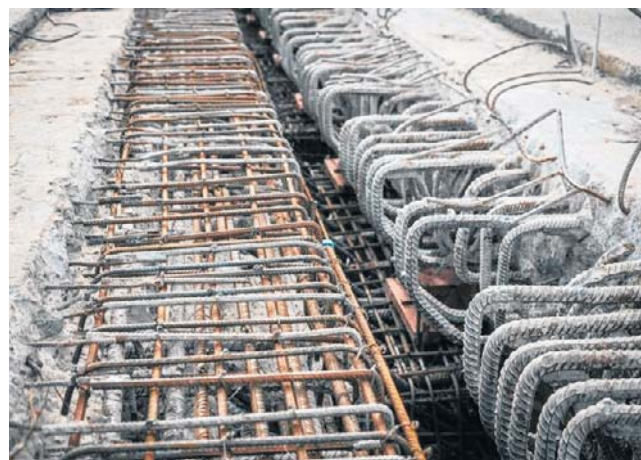
Zbrojenie dolnej części przegubu Estakady
