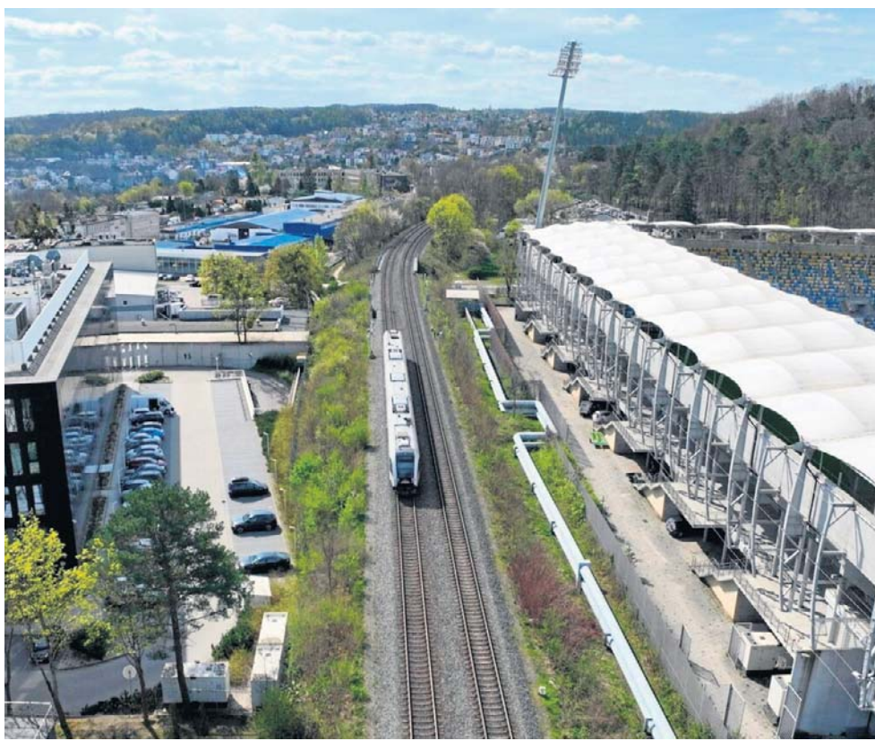
Modernizacja obejmie fragment linii kolejowych nr 201 i 202
