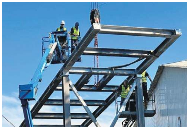
PEC w Wałbrzychu jest już prawie na finiszu inwestycji.
