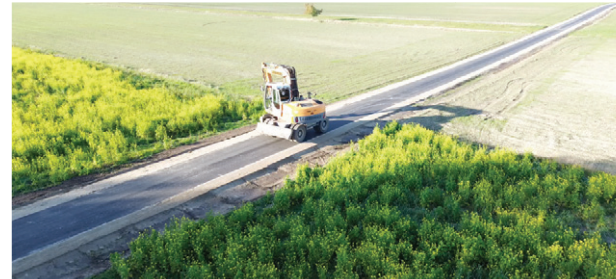
Prace w ramach zagospodarowania poscaleniowego w miejscowości Wygoda
