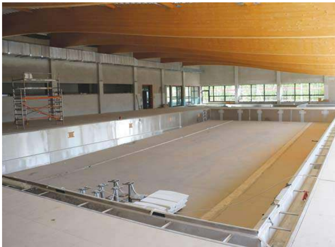
Intensywne prace budowlane trwają zarówno wewnątrz, jak i na zewnątrz obiektu
