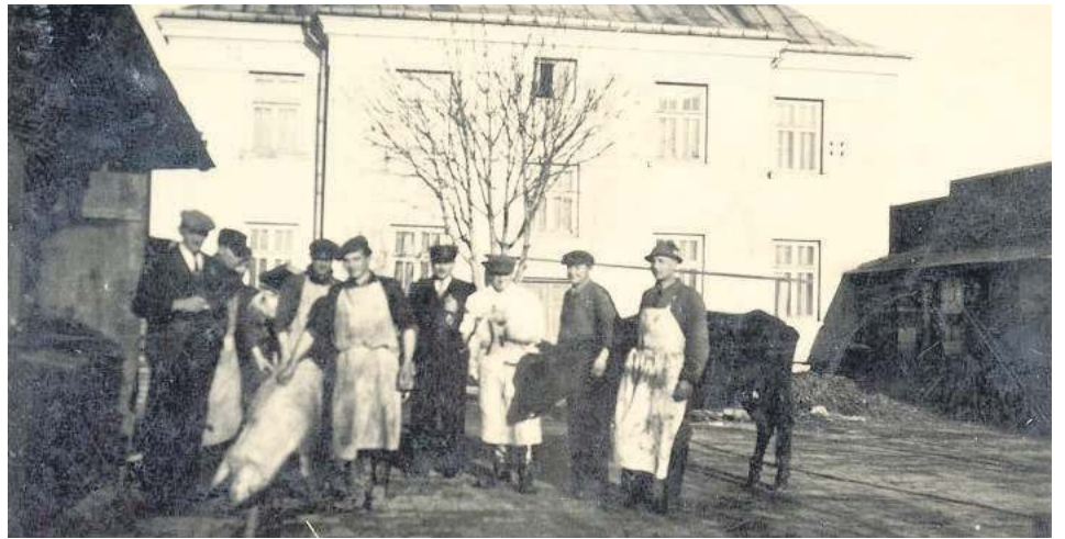
Zdjęcie wykonano w latach 30. ub. wieku, przed zakładem rzeźniczym Jana Misztala w Zamościu, przy ul. Kilińskiego. Fotografiię do APZ przekazała Jolanta Klimko.
