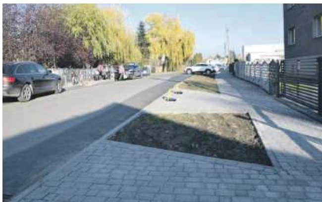
W Psarach na ul. Polnej zostały wybudowane chodniki, miejsca parkingowe oraz przejścia dla pieszych
