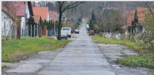
Betonowe płyty na ul. H. Pobożnego w Obornikach, w wielu miejscach z ubytkami i dziurami, zastąpi kostka betonowa. Powstanie też chodnik.
