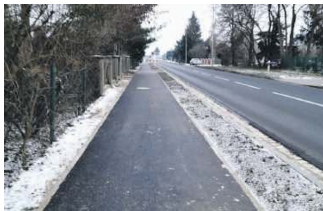
W Szewcach zakończyła się budowa chodnika przy drodze wojewódzkiej nr 342
