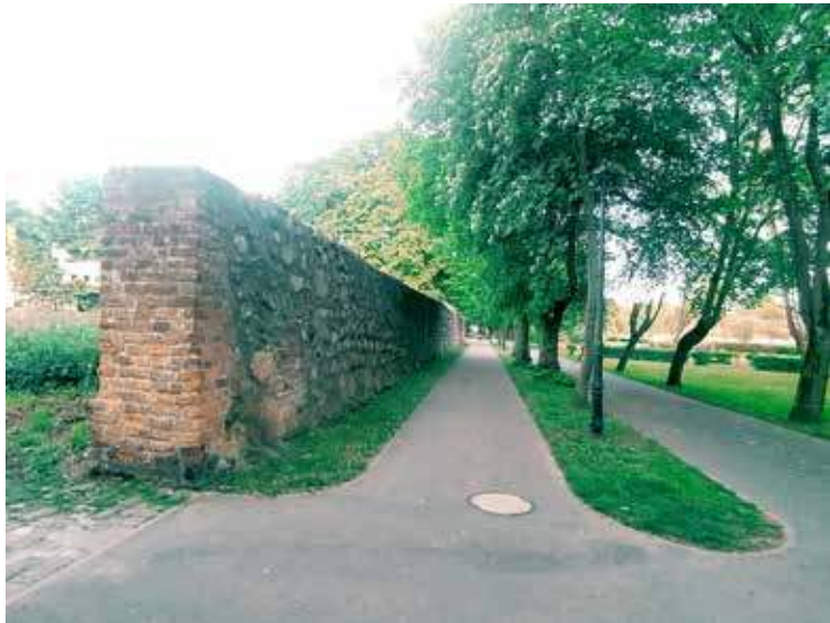
Mury miejskie pomiędzy Placem Wolności a jeziorem to jeden z najbardziej charakterystycznych zabytków w gminie
