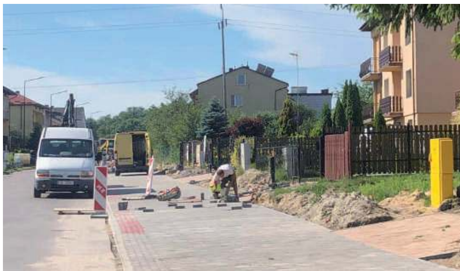
Budowa chodnika na Bagiennej idzie pełną parą
