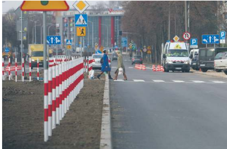
Wyremontowana ulica Raclawicka wymaga poprawek
