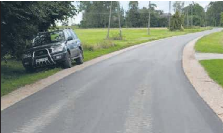
Przebudowa – modernizacja odcinka drogi powiatowej nr 1458W Sanniki – Ilów
