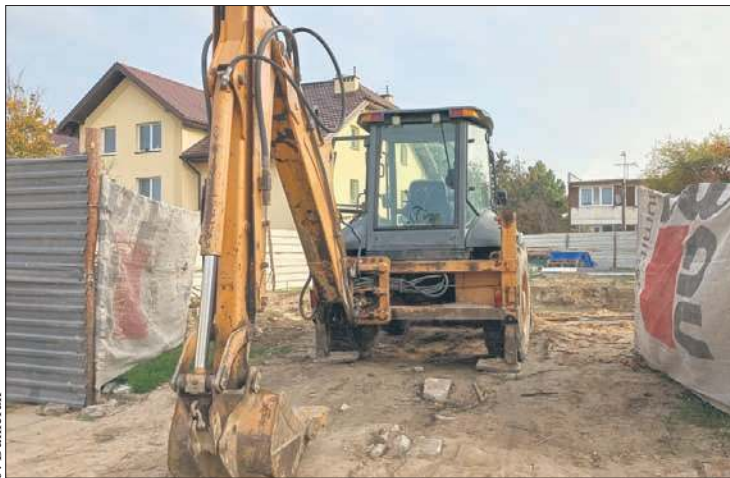
Budowa nowego bloku przy ul. Miodowej 27
