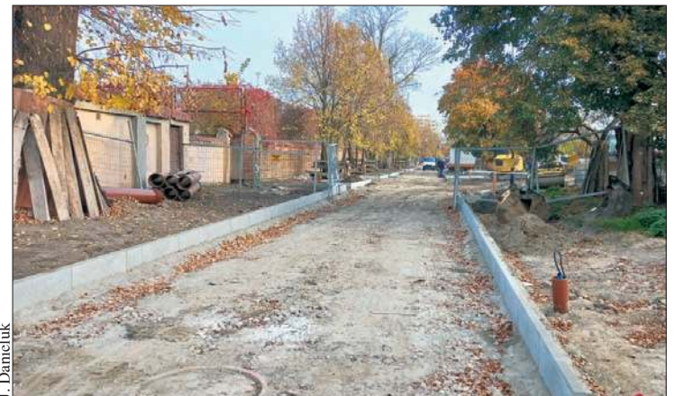
Trwa przebudowa al. Spacerowej
