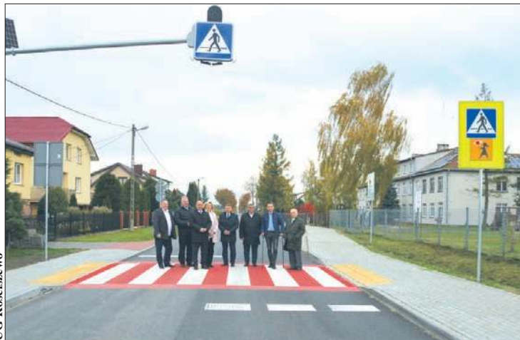
W ramach powiatowo – gminnej współpracy przebudowano cztery odcinki dróg powiatowych na terenie gminy Rościszewo
