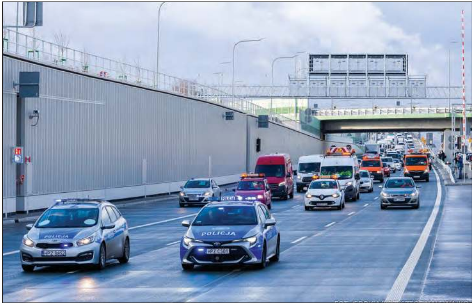
Wartość inwestycji, w której skład wchodzi m.in. wykonanie dokumentacji, wykupy gruntów, wykonanie robót oraz nadzór to ok. 1,66 mld zł. Koszt samych prac budowlanych to około 1,2 mld zł
