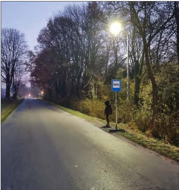
W Izdebnie-Kolonii rozbudowano oświetlenie na długości 1000 metrów przy drodze powiatowej
