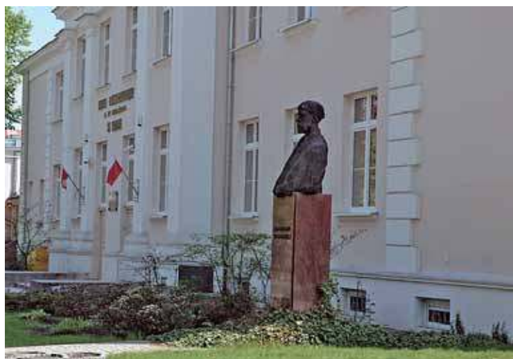
W ramach wakacyjnych remontów naprawiono dach i oczyszczono elewację na budynku I LO im. Stanisława Wyspiańskiego
