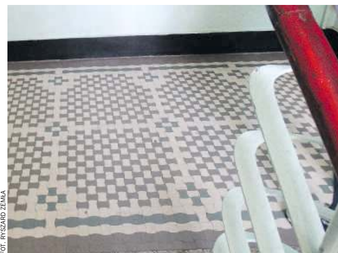
Goresciki na kładce schodowej w domu przy ul. Wyszyńskiego
