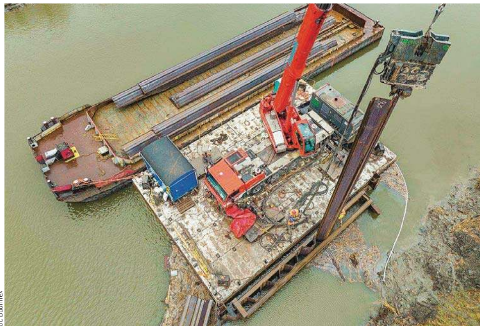
W kwietniu 2022 minie rok od podpisania kontraktu na realizację drugiego etapu budowy drogi wodnej łączącej Zalew Wiślany z Zatoką Gdańską
