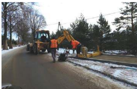
Remontowane i wyremontowane odcinki „wielkiej pętli”
