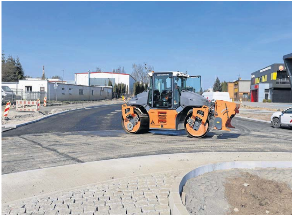
Asfaltowanie fragmentu ringu na ul. Słonecznej
