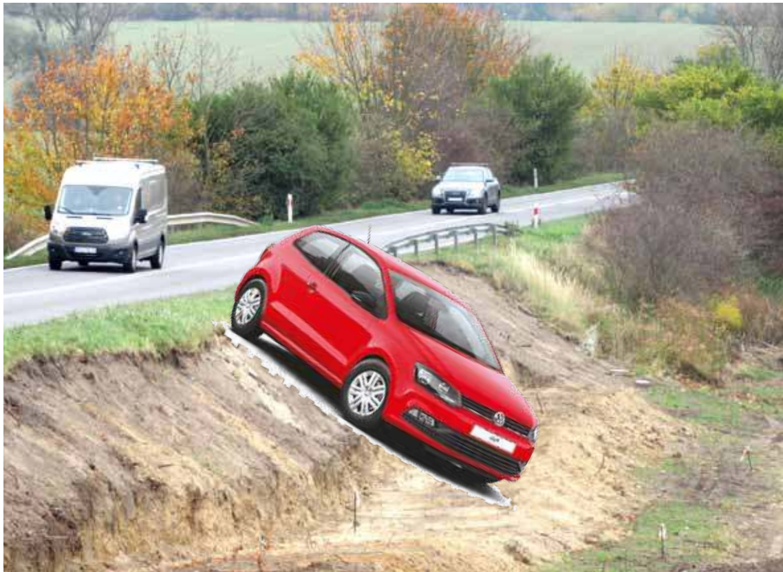
Stara barierka zasłania tylko przepust
