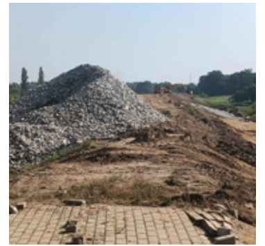
Inwestorem są Wody Polskie.
