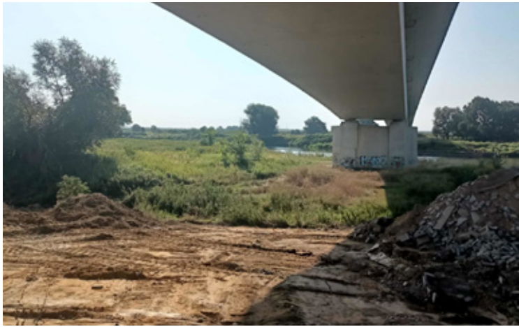
Obecne prace przy wałach.
