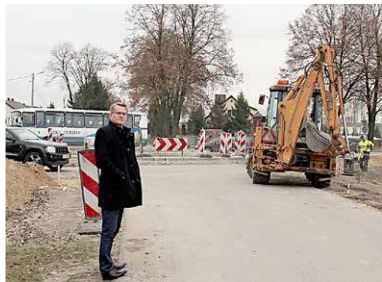
Fot. Arch. Starostwa Powiatowego w Łukowie
