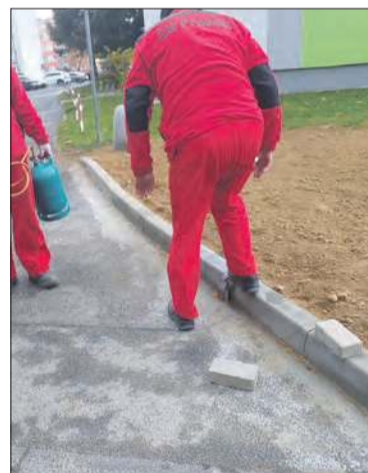
Prace przy budowie krawężników
