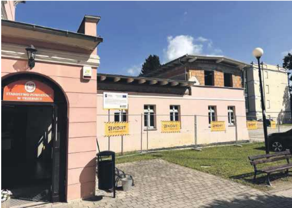
Remont oficyny ma kosztować kilka milionów
