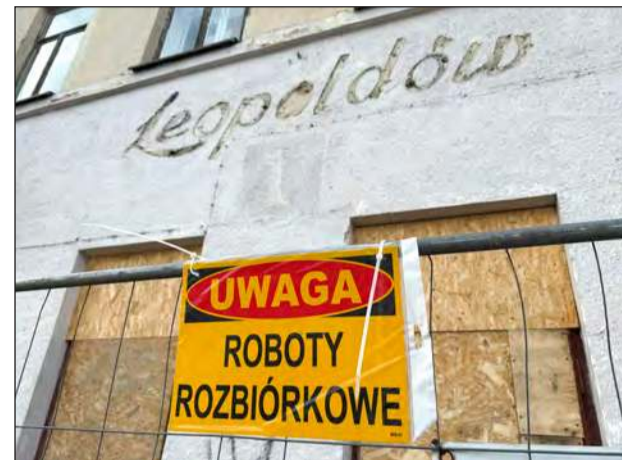
Robotnicy szacują, że rozbiórka zajmie około dwóch tygodni
