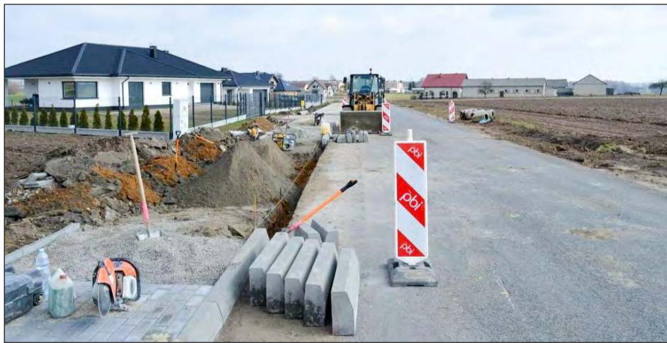
➤ Trwa przebudowa drogi powiatowej między Kłoczewem, Jagodnem a Gozdem. Powstaną nowe chodniki, przejścia dla pieszych i zjazdy do posesji
