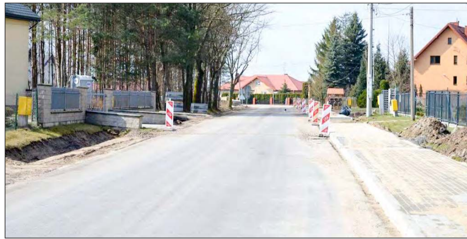
➤ Droga zyska nową nawierzchnię o szerokości 6 metrów
