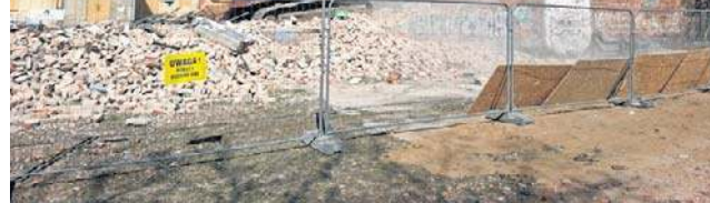
Przy ulicy Rycerskiej 5 zostały wyburzone budynki oficyn mieszkalnych
