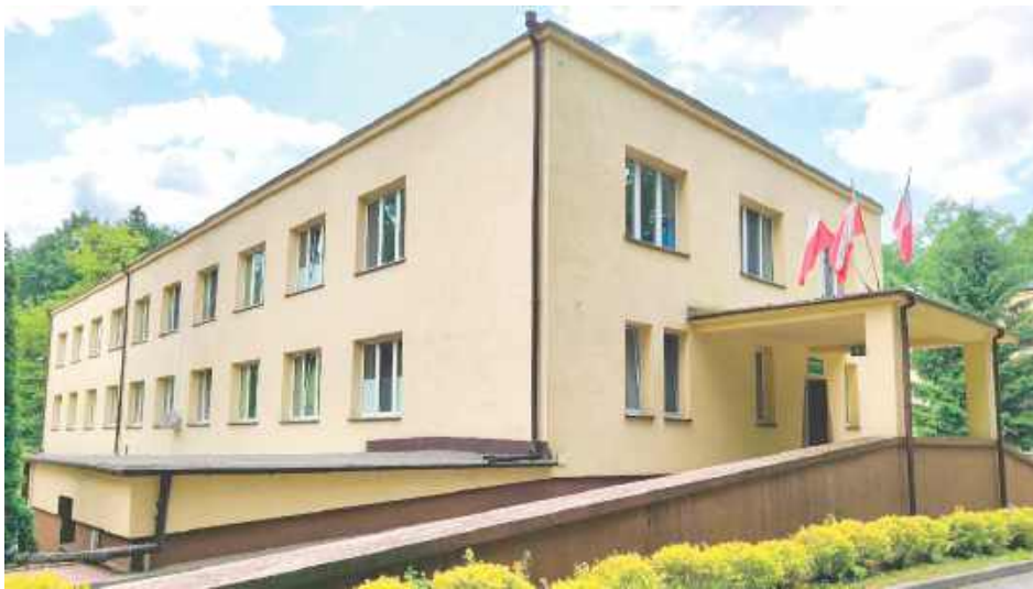
W Poradni Gruźlicy i Chorób Płuc w Poniatowej rozpoczął się generalny remont. To pierwsza od przeszło 30 lat taka kompleksowa inwestycja
