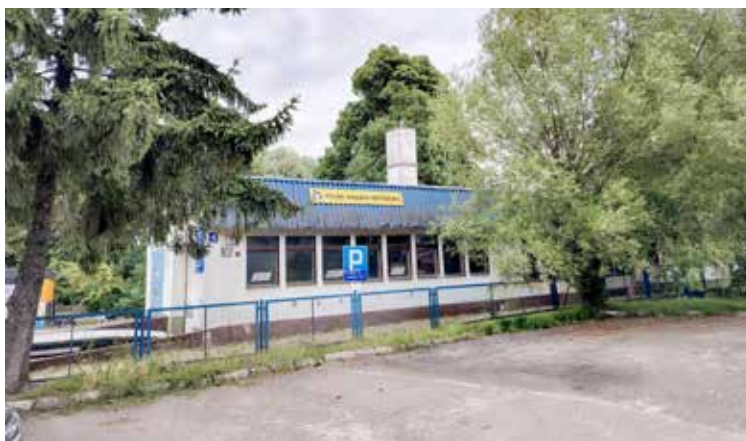
Budynek handlowo-usługowy ma postać w miejscu po byłym PZMot
