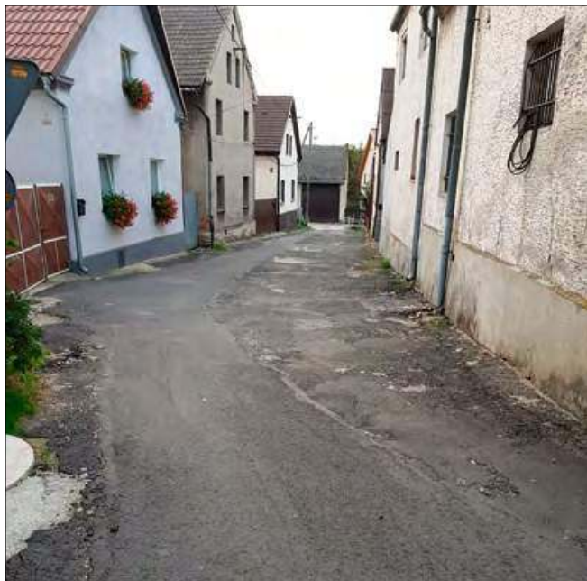
W przyszłym roku przebudowana zostanie ulica Wodna na odcinku biegnącym od miejscowej gospody...
