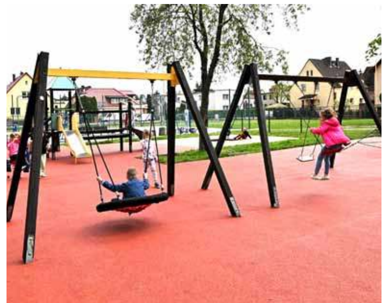
Na placu zabaw położono prawie 300 m 2 nowej, poliuretanowej nawierzchni
