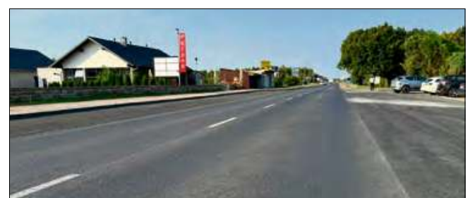
Fragment drogi pomiędzy Krapkowicami a Stebłowem został oddany do użytku.
