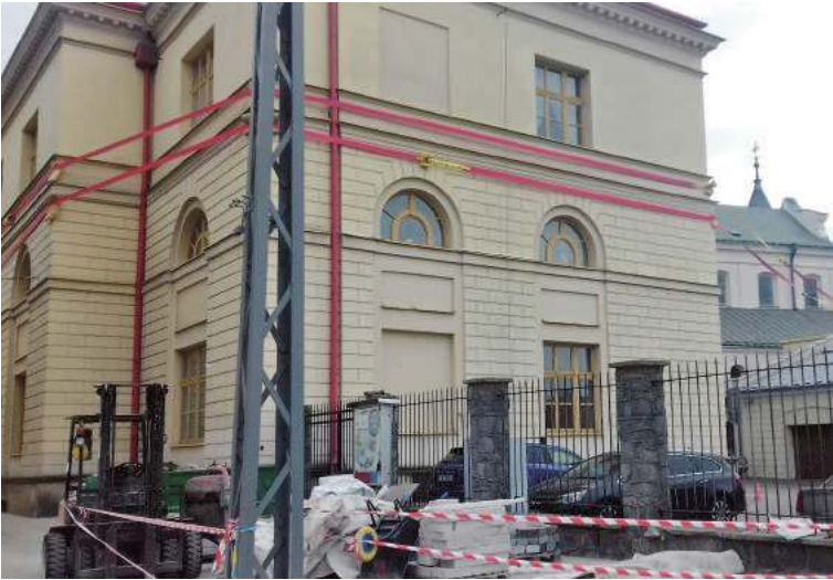
U przechodniów okalające ratusz taśmy wywołują obawy o stan techniczny budynku
