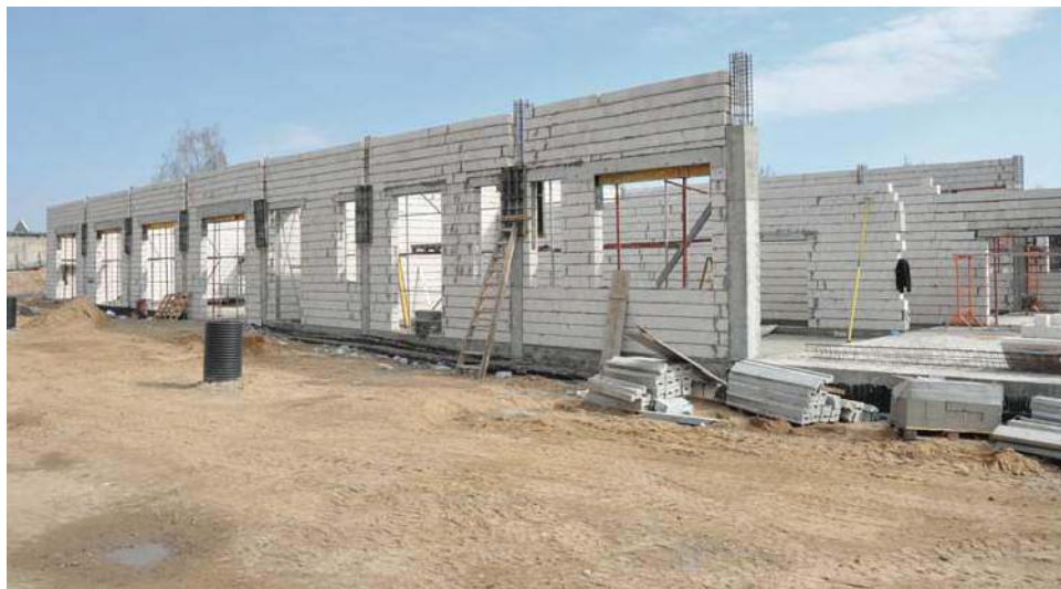
Budowa hali warsztatowej Centrum Kształcenia Zawodowego w Elku
