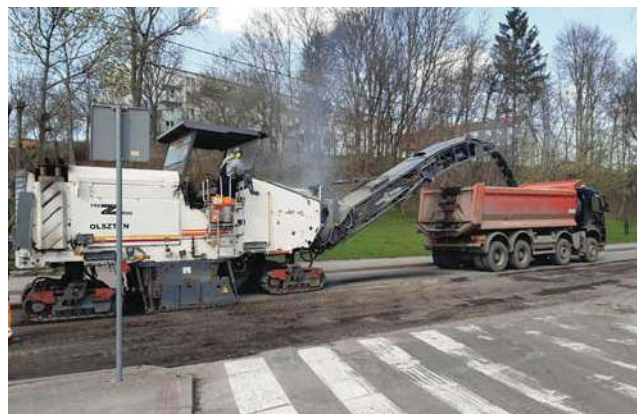
Trwają prace remontowe wokół Kętrzyńskiego Jeziora
