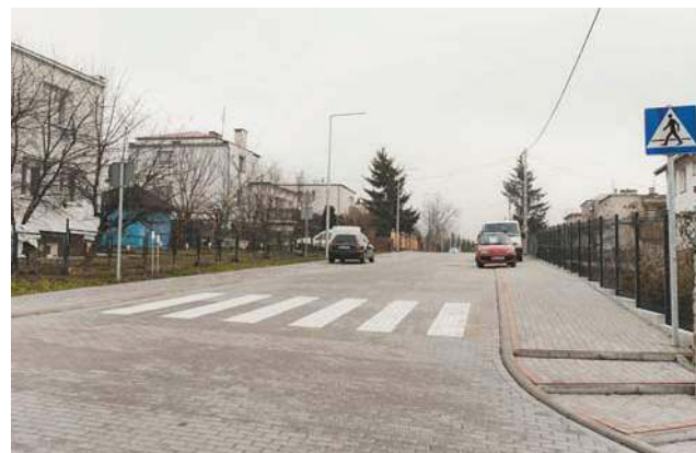
Wyremontowana ulica Olsztyńska
