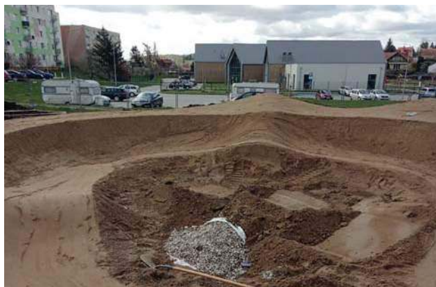
Pumptrack w budowie
