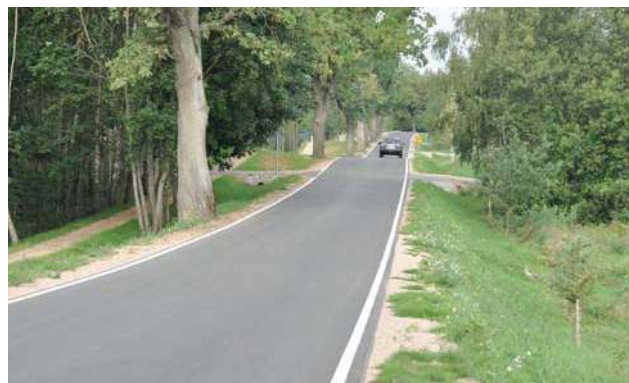
Droga powiatowa na odcinku Sajzy-Piaski po przebudowie
