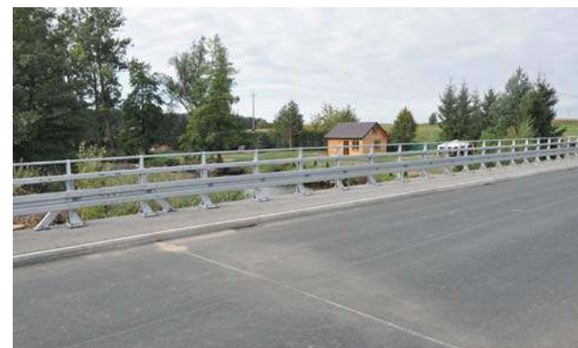
Most w Milukach po modernizacji
