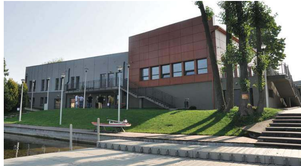
Międzyszkolny Ośrodek Sportowy w Elku po przebudowie
