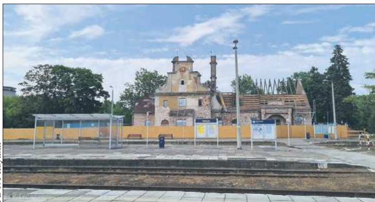
Prace remontowe zabytkowego dworca mają być zakończone w październiku przyszłego roku
